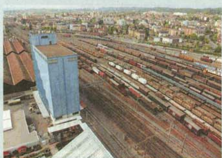
Gare de triage de Renens Demain, les CFF n'utiliseront plus qu'un quart des voies.
